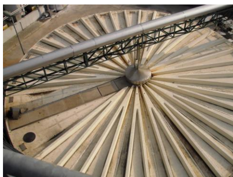
Figura 12: Sedimentatore primario
