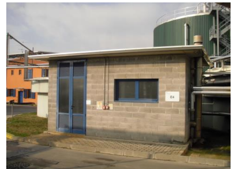
Figura 19: Locale caldaia, E4
