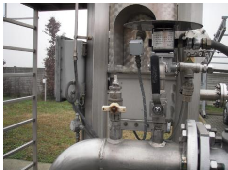
Figura 21: Beccuccio di prelievo del biogas
