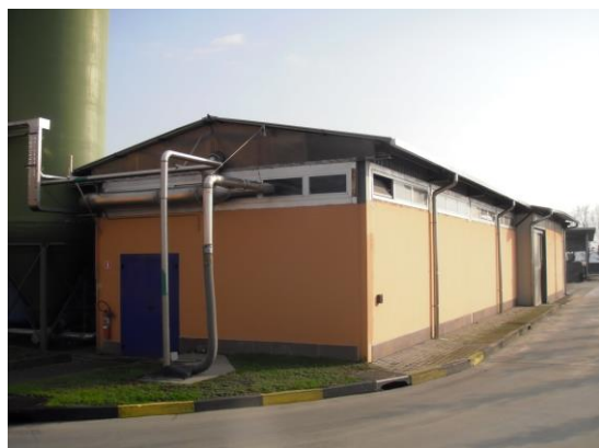
Figura 15: Locale filtopresse disidratazione fanghi biologici e chimici
