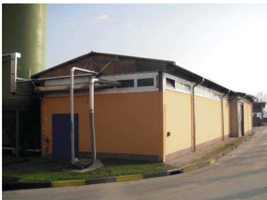
Figura 15: Locale filtropresse disidratazione fanghi biologici e chimici
