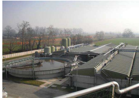
Figura 13: Comparto biologico e sedimentazione finale
