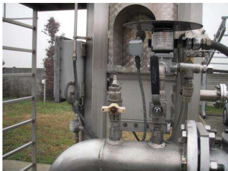
Figura 21: Beccuccio di prelievo del biogas
