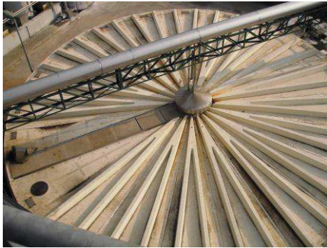
Figura 12: Sedimentatore primario
