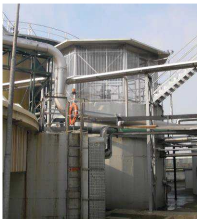
Figura 10: Sedimentatore Chimico-fisico
