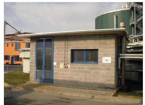
Figura 19: Locale caldaia, E4
