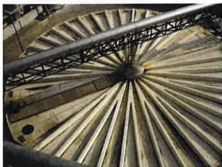
Figura 13: Sedimentatore primario
