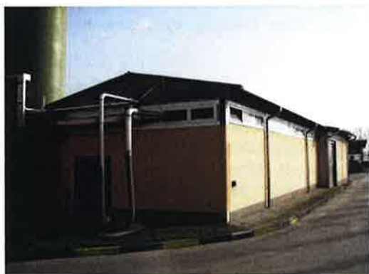
Figura 16: Locale filtopresse disidratazione fanghi biologici e chimici
