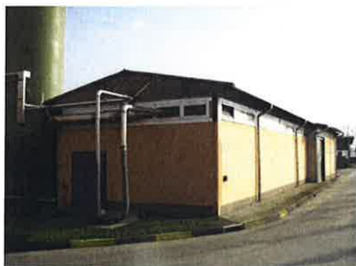
Figura 16: Locale filtropresse disidratazione fanghi biologici e chimici
