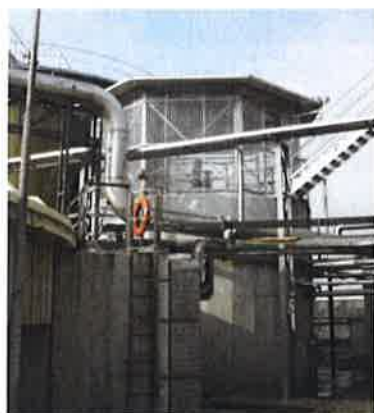
Figura 11: Sedimentatore Chimico-fisico
