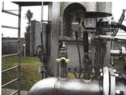
Figura 22: Beccuccio di prelievo del biogas
