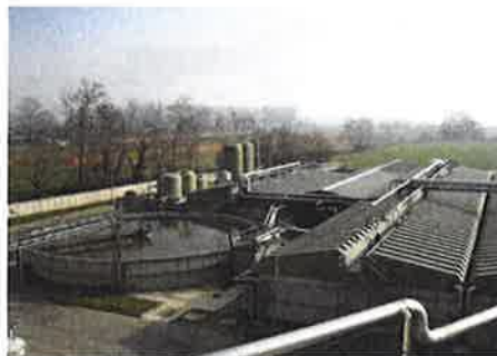
Figura 14: Comparto biologico e sedimentazione finale
