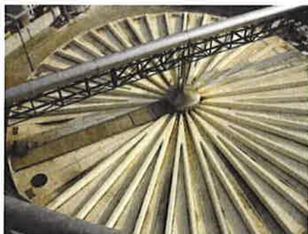
Figura 13: Sedimentatore primario
