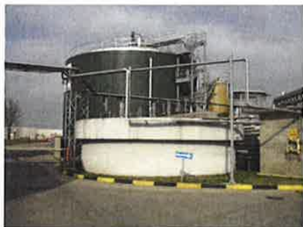
Figura 15: Ispessitore e digestore fanghi biologici
