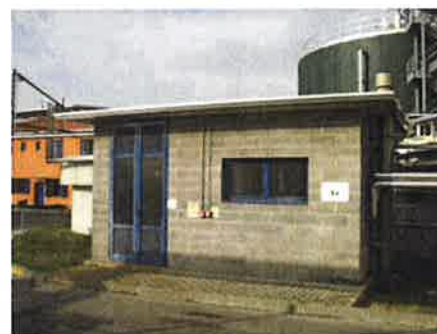
Figura 20: Locale caldaia, E4
