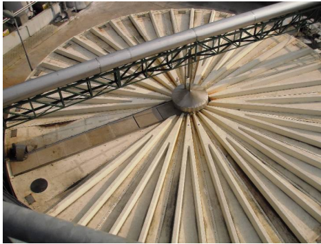
Figura 13: Sedimentatore primario
