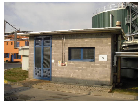
Figura 20: Locale caldaia, E4
