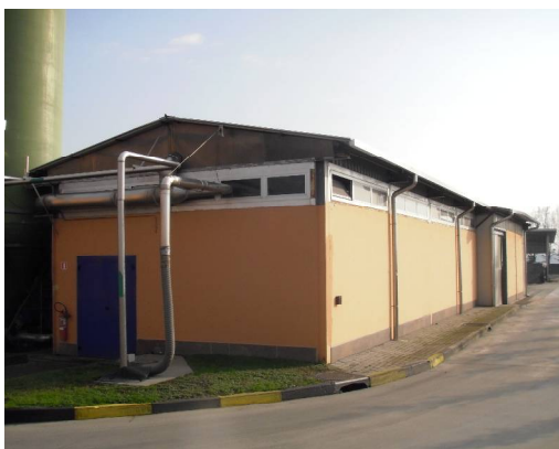
Figura 16: Locale filtropresse disidratazione fanghi biologici e chimici
