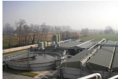
Figura 14: Comparto biologico e sedimentazione finale
