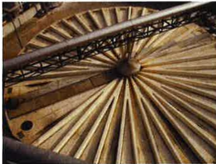
Figura 13: Sedimentatore primario
