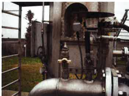
Figura 22: Beccuccio di prelievo del biogas
