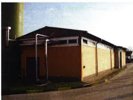
Figura 16: Locale filtopresse disidratazione fanghi biologici e chimici
