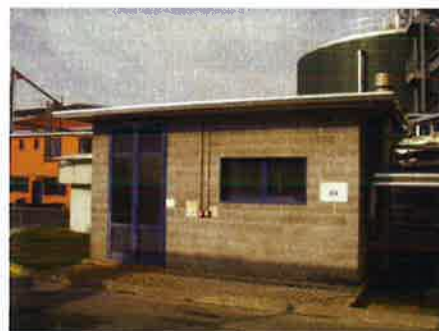
Figura 20: Locale caldaia, E4
