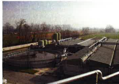
Figura 14: Comparto biologico e sedimentazione finale
