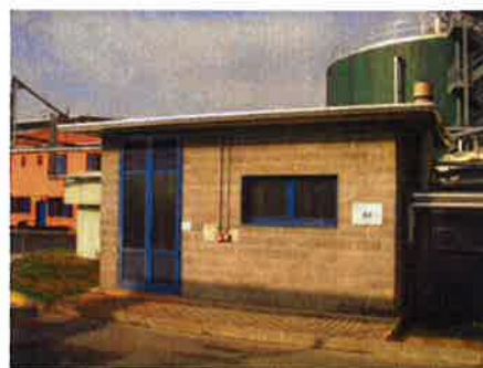
Figura 20: Locale caldaia, E4
