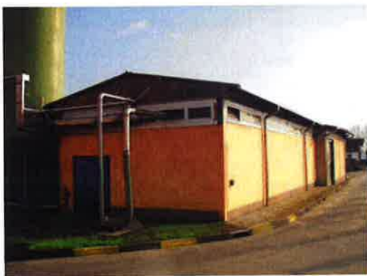
Figura 16: Locale filtropresse disidratazione fanghi biologici e chimici
