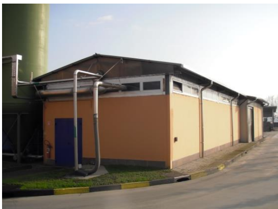
Figura 16: Locale filtropresse disidratazione fanghi biologici e chimici
