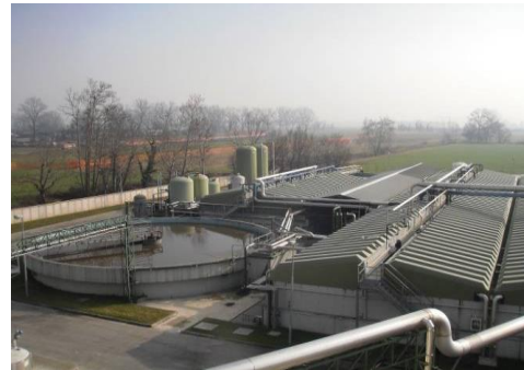
Figura 14: Comparto biologico e sedimentazione finale
