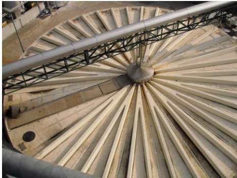
Figura 13: Sedimentatore primario
