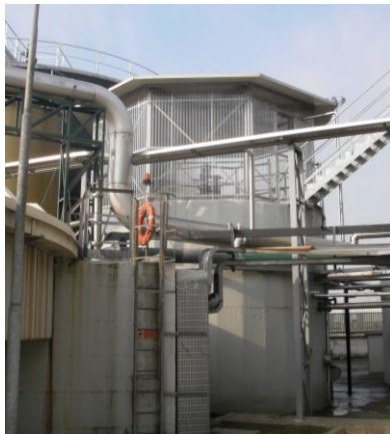
Figura 11: Sedimentatore Chimico-fisico
