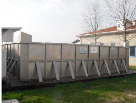
Figura 17: Biofiltro Syntal, E1
