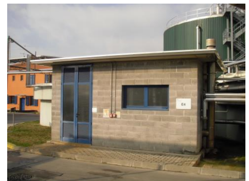
Figura 20: Locale caldaia, E4
